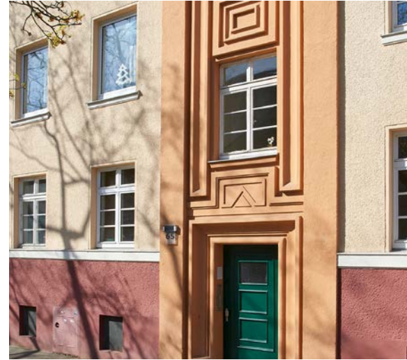
BERCKHUSENSTRASSE 65 ERNEUERUNG DER UNTER DENKMAL- SCHUTZ STEHENDEN FENSTER.
