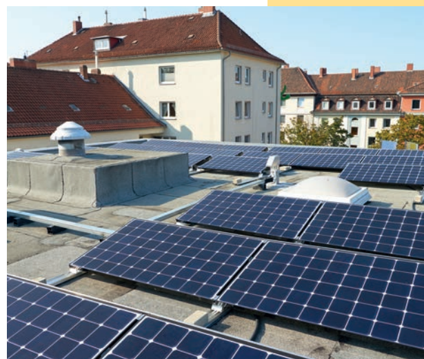
BERCKHUSENSTRASSE 16 ZWEITE AUSBAUSTUFE DER PHOTOVOLTAIKANLAGE.
