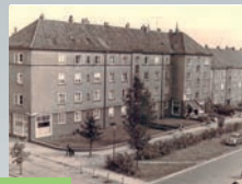
1940 Schweriner Straße 2 Stenhusenstraße 1 – 7
