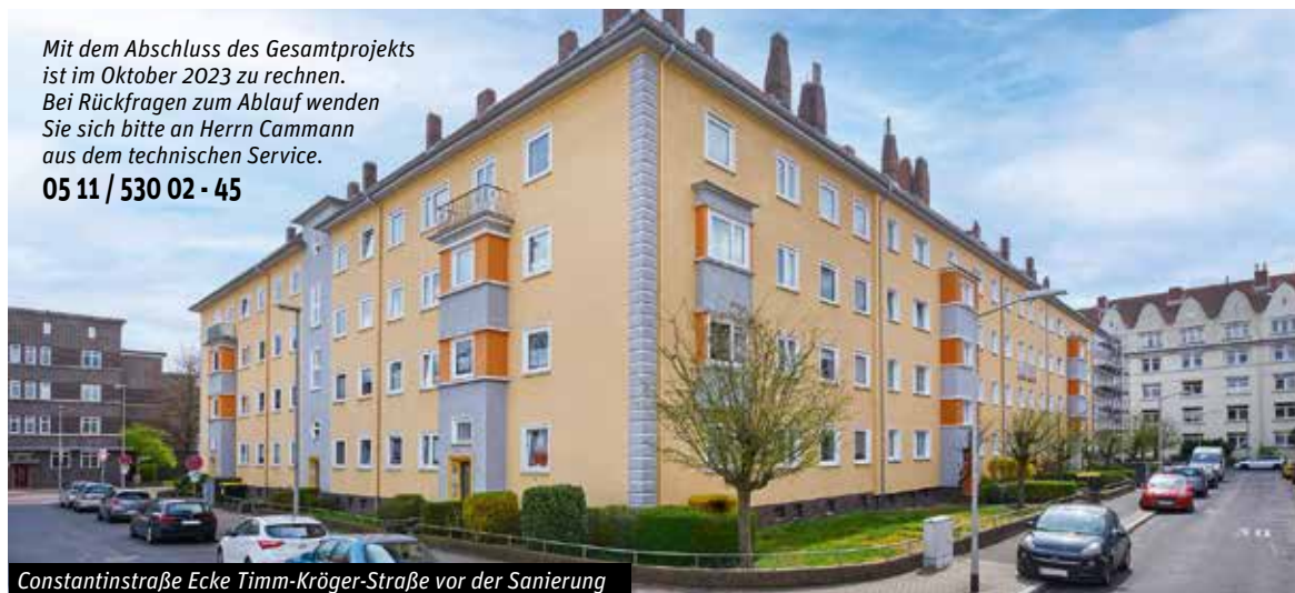
Constantinstraße Ecke Timm-Kröger-Straße vor der Sanierung
